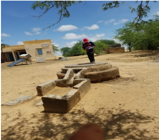
Etat du puits a grand diamètre CScom Mekoré
